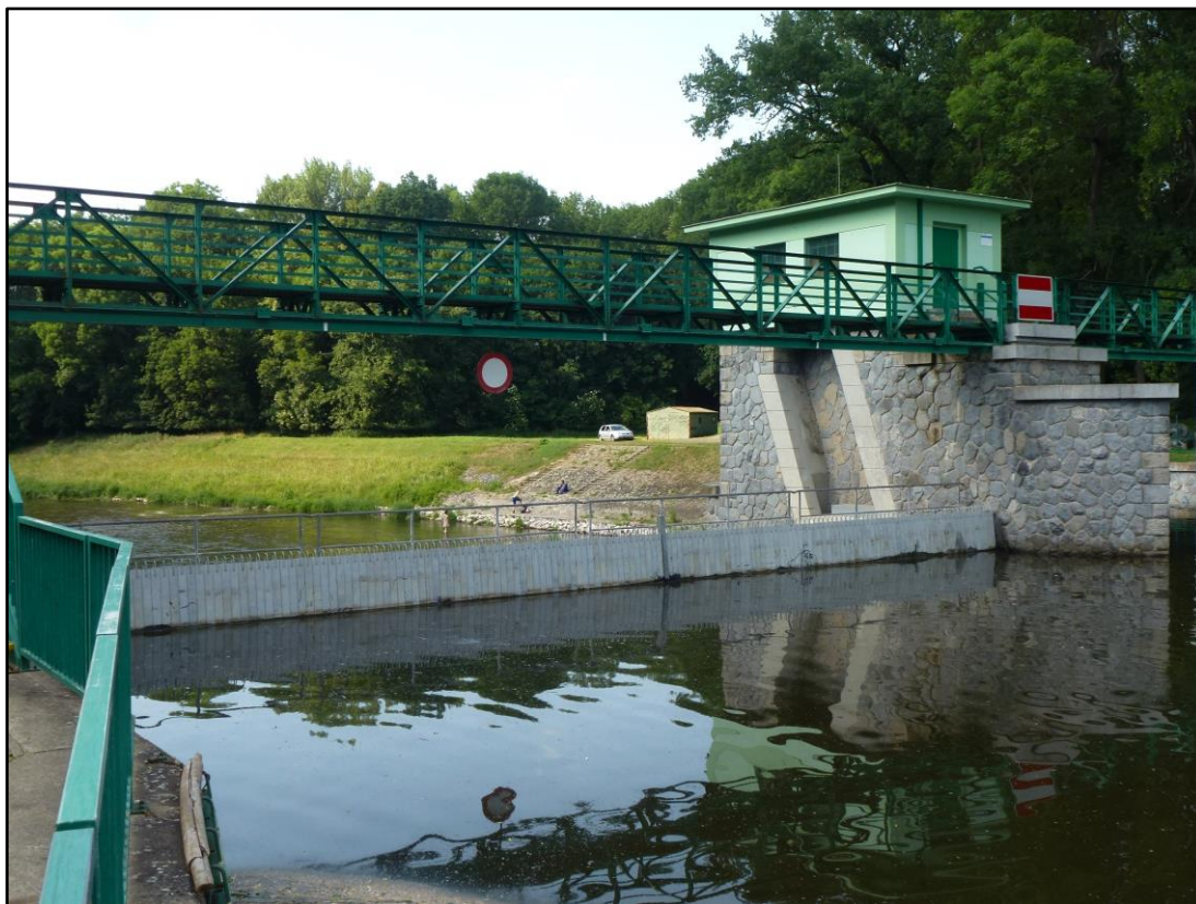
Foto č. 6 – Provizorní hrazení z horní vody po montáži (pohled z podjezí VD)
