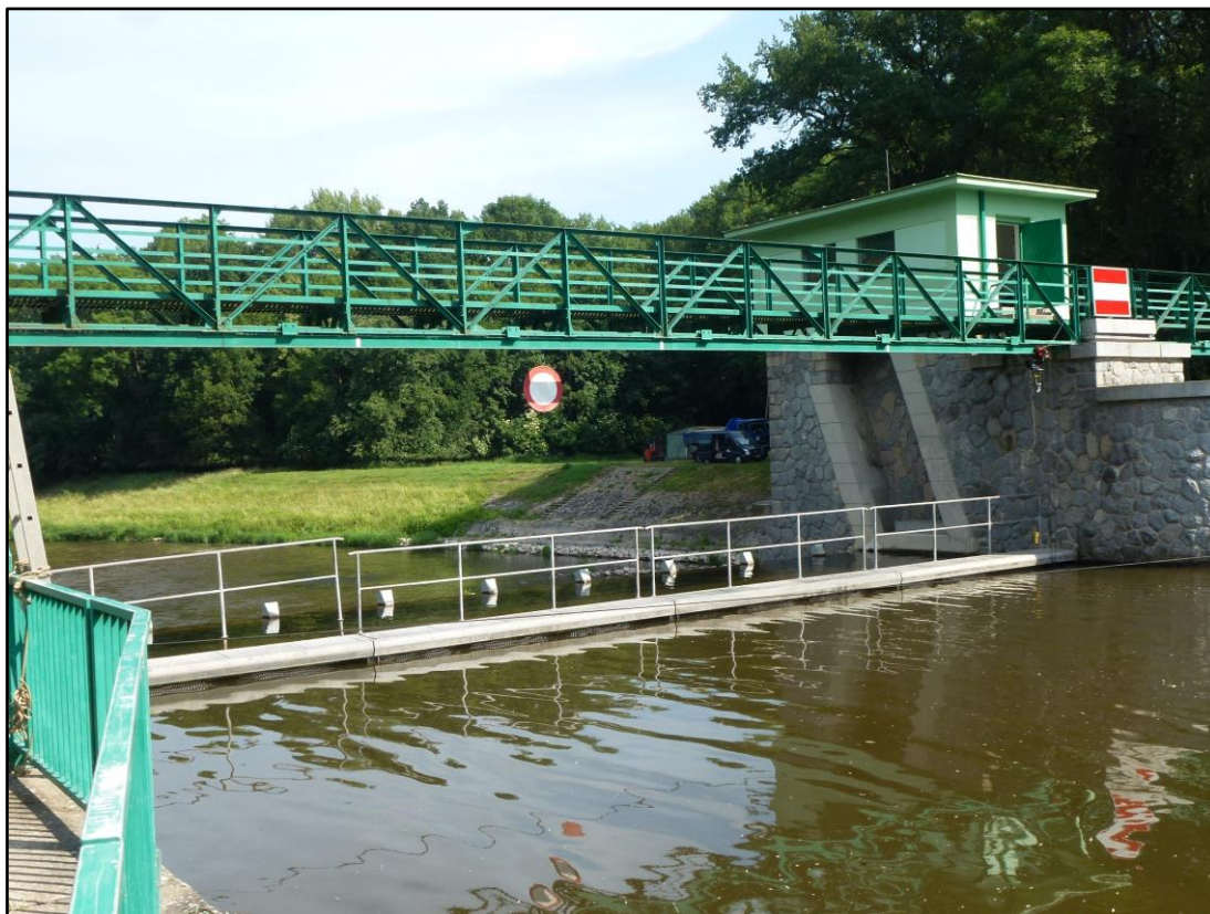
Foto č. 4 – Provizorní hrazení z horní vody v průběhu prací (pohled z podjezí VD)
