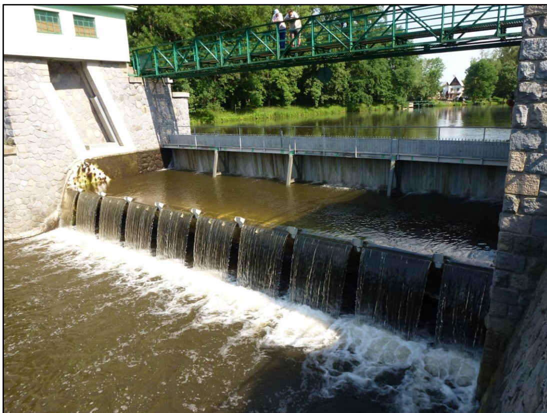
Foto č. 4 – Provizorní hrazení z horní vody v průběhu prací (pohled z podjezí VD)
