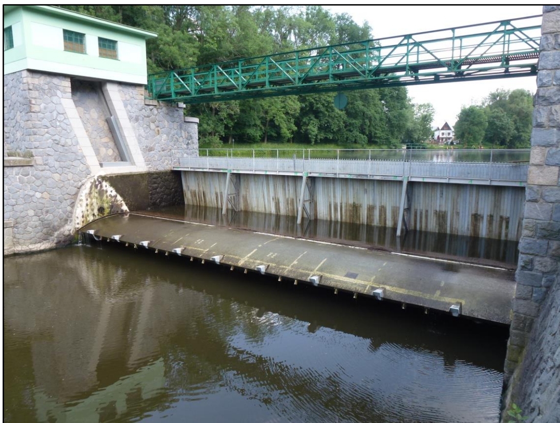
Foto č. 6 – Provizorní hrazení z horní vody po montáži (pohled z podjezí VD)
